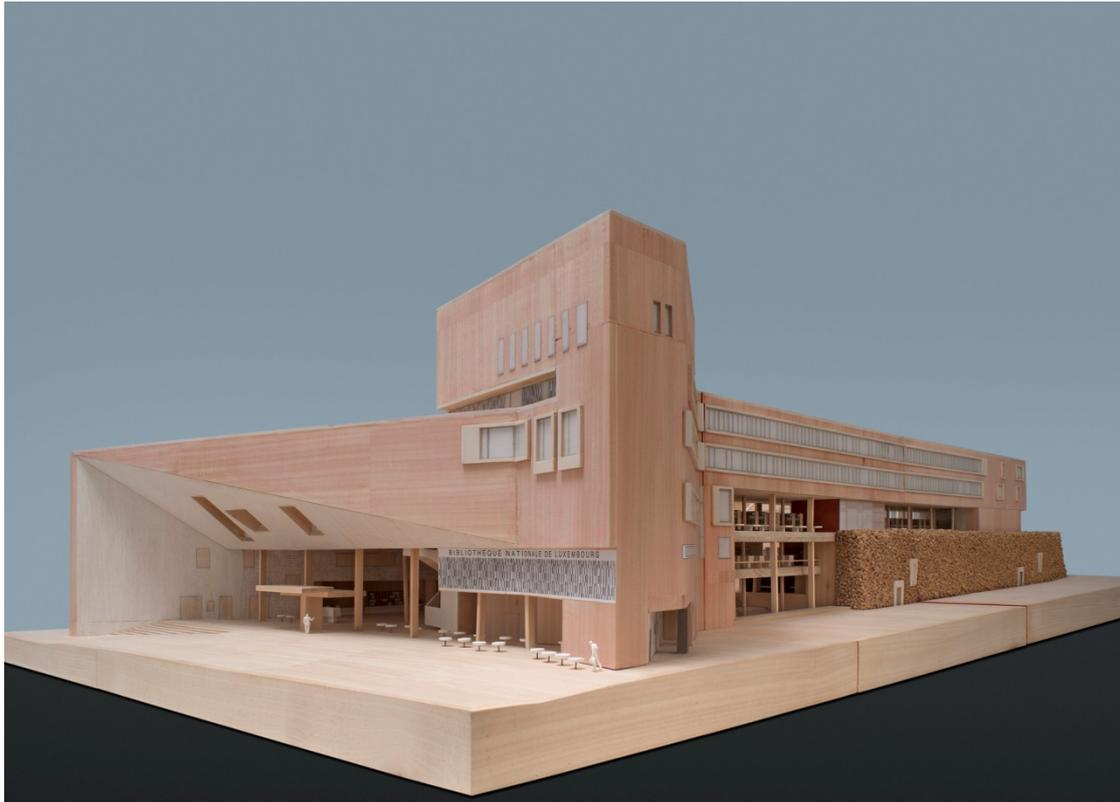
Des références régionales et propres au site ont été prises en compte et thématisées dans les couleurs et les matériaux des façades. Le soubassement du bâtiment est par exemple réalisé en gabions en utilisant les matériaux en provenance des pierres concassées issues des travaux de fouille dans la roche.
